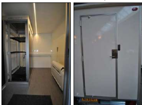
Serverrum med aircondition, serverrack og indgangsdør med kodelås
